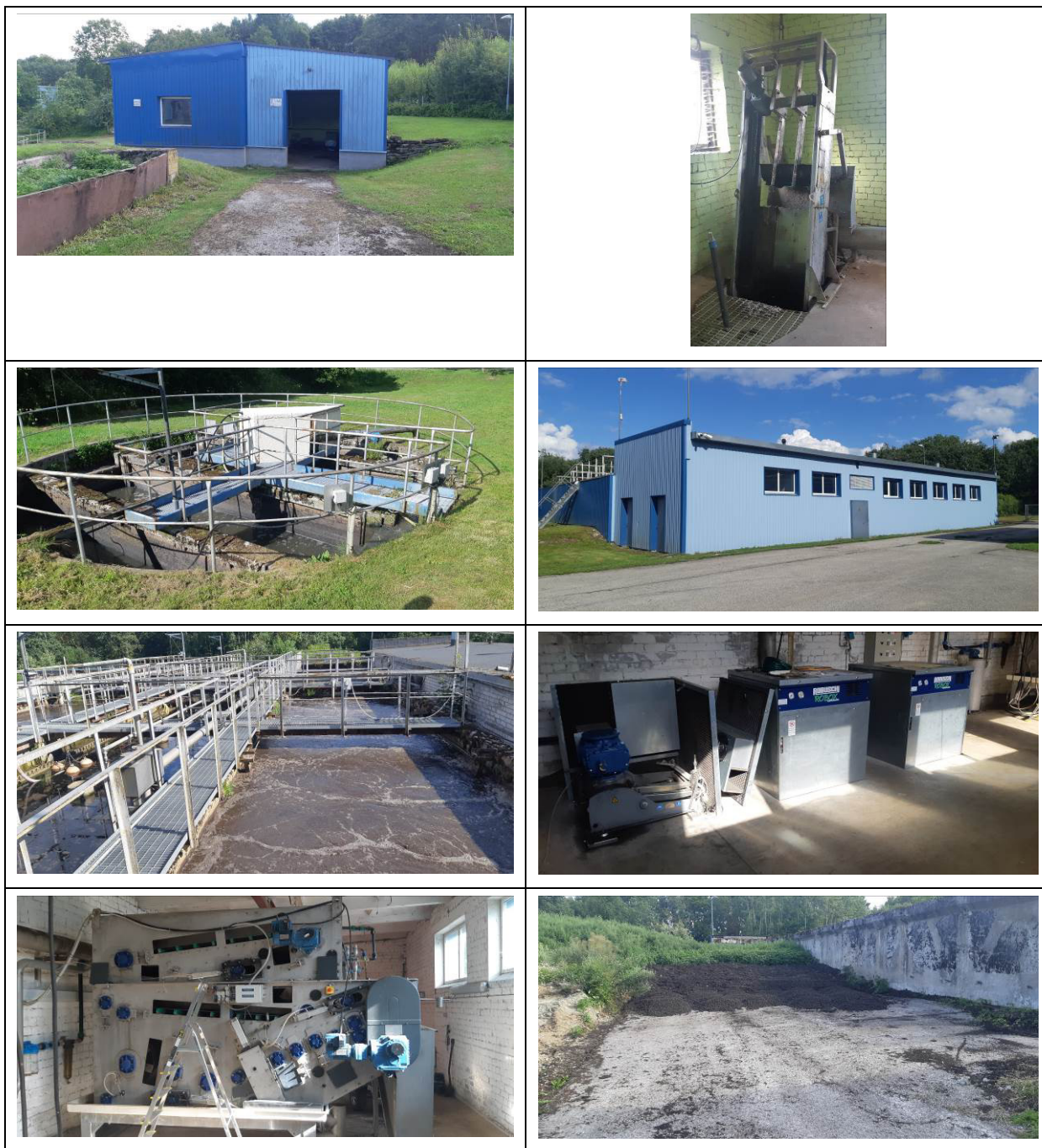
Joonis 5. Kunda linna reoveepuhasti. Fotod: OÜ Alkranel 18.07.2024.
